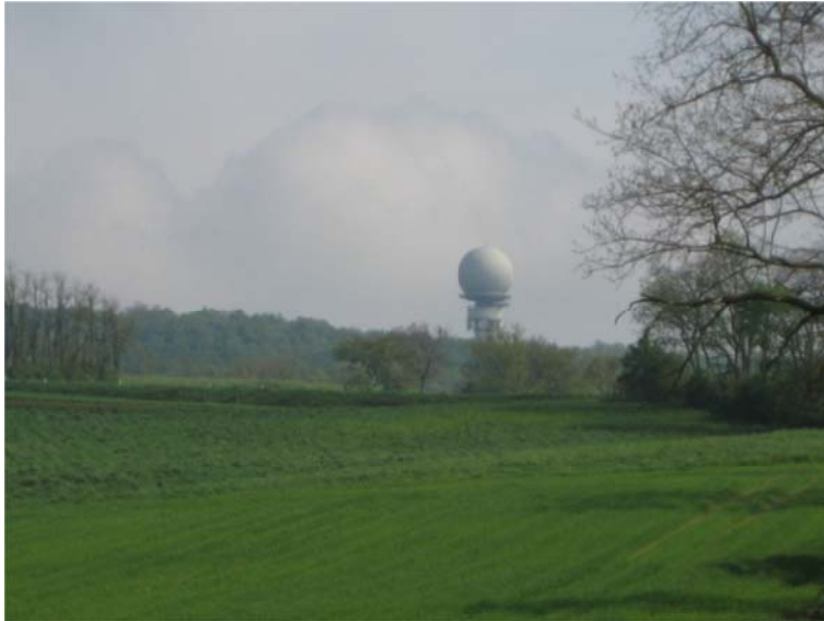
Abbildung 11: Radaranlage Steinmandl im Landschaftsschutzgebiet (Quelle: UVE)
