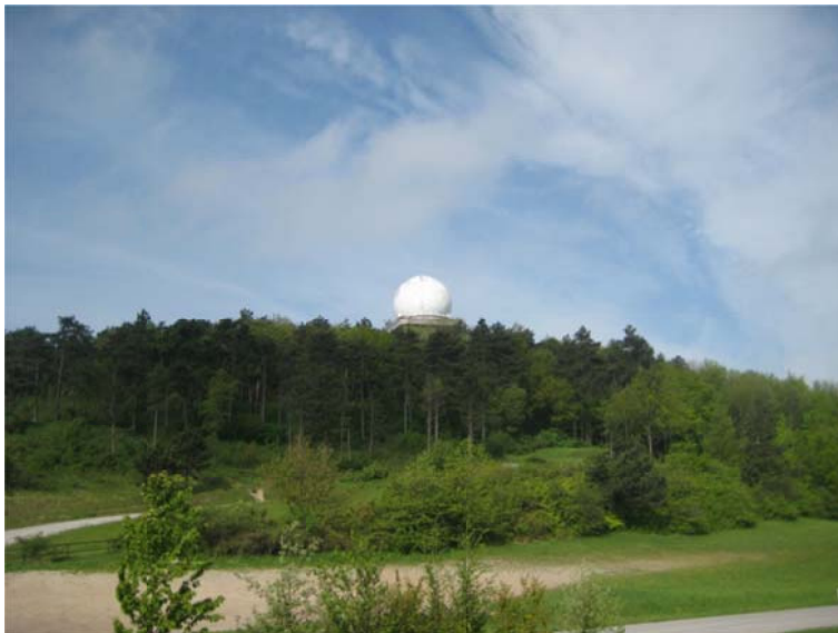
Abbildung 10: Parkplatz zur Buschberghütte mit Radaranlage am Buschberg im Landschaftsschutzgebiet (Quelle: UVE)
