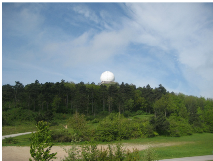
Abbildung 14: Parkplatz zur Buschberghütte mit Radaranlage
